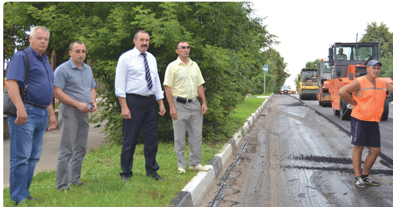
■ В Зарайском районе ежегодно ведется большой объем строительства и ремонта дорог. В 2015 году всего отремонтировано в срок 16 дорог местного значения протяженностью в 7,8 километра. На очереди одна из заурядных улиц города Зарайска – Ленинская
