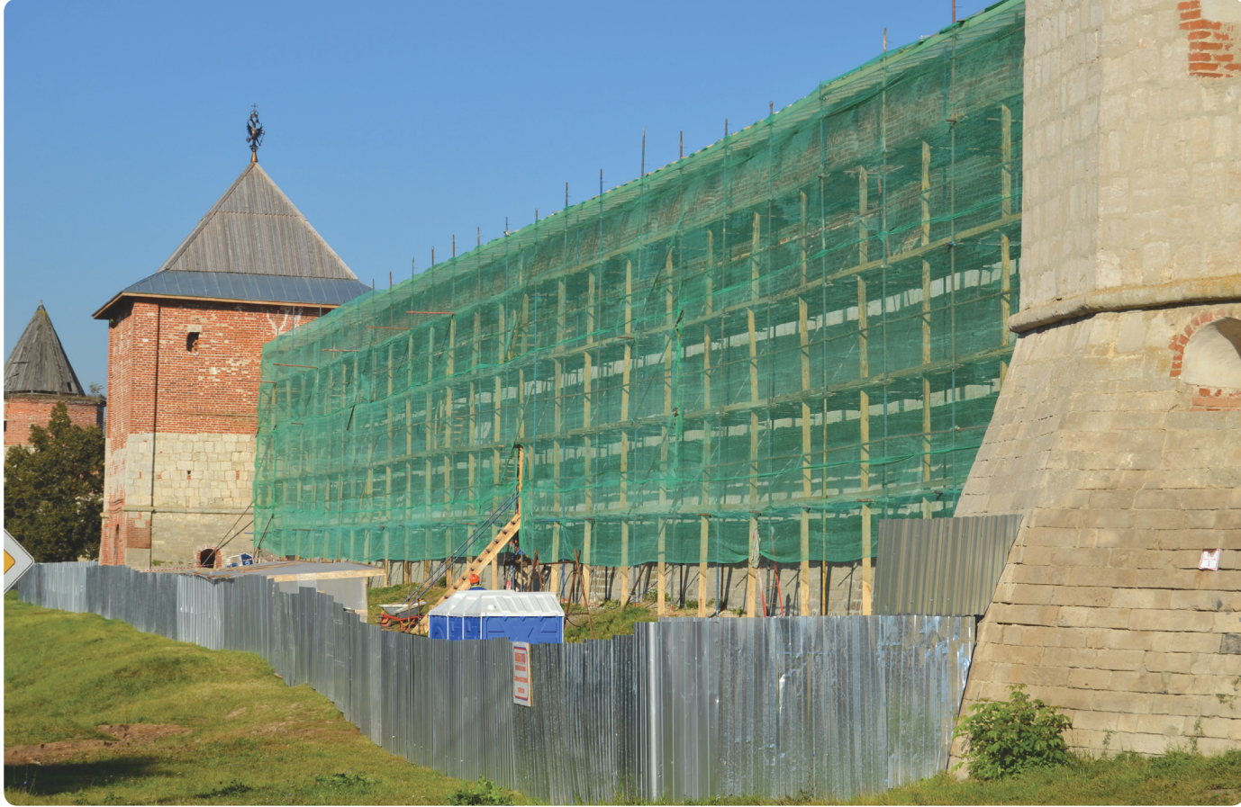
■ Полным ходом идут реставрационные работы между Кабачкой и Спасской башнями Зарайского Кремля. К 2018 году планируется полностью отреставрировать главную достопримечательность Зарайска
